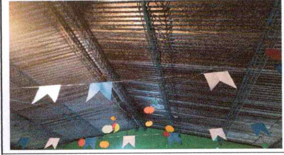
FOTO 2: Sustrucción de estructura de soporte de metal por metal
