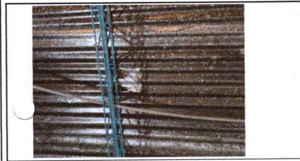
FOTO 5: MANO DE OBRA Instalación de estructura portante de metal
