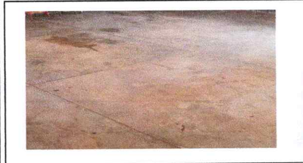
FOTO 3: Sustrucción de piso liquido por piso cerámico
