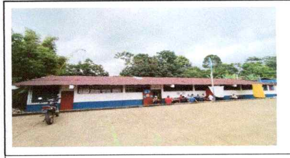
FOTO 6: MANO DE OBRA Intalación de lámina troquelada aluzinc
