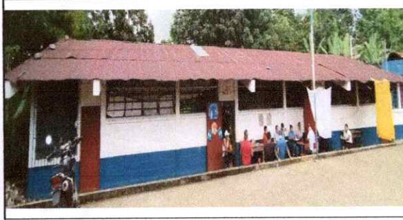
FOTO 4: Instalacion de canal de metal
